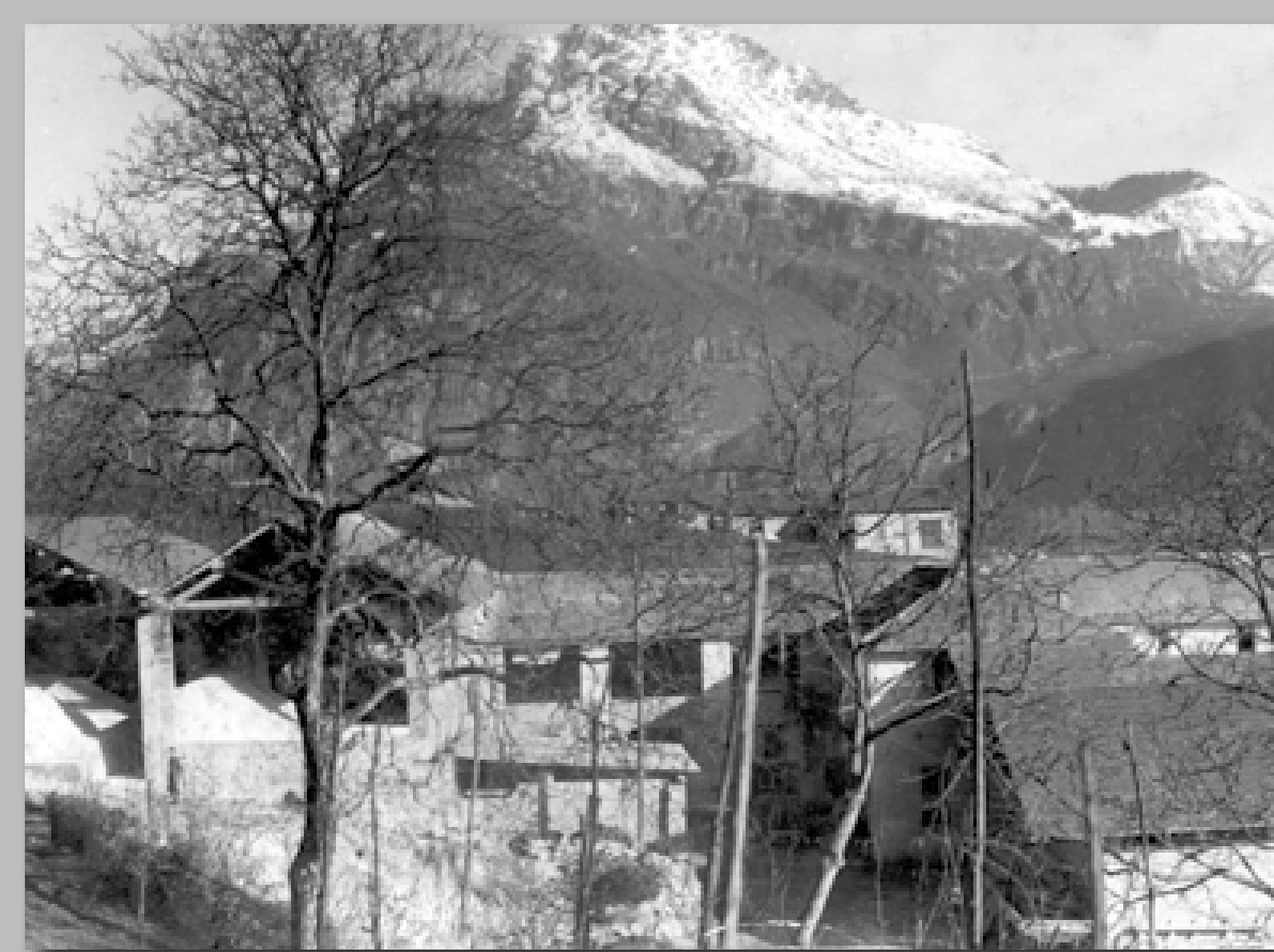
Scorcio interno dello stabilimento Maffei
