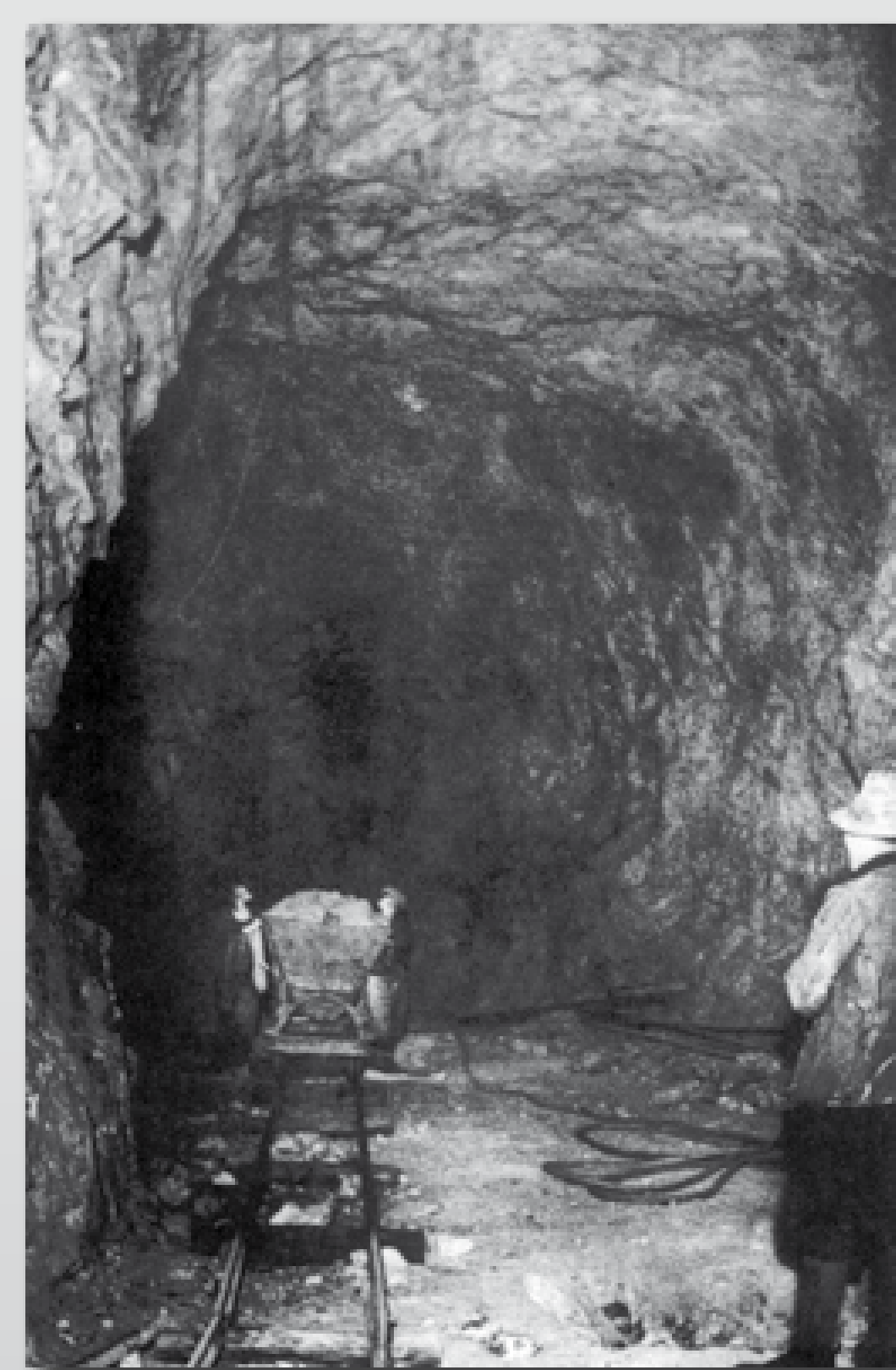
Interno di una galleria, miniera di Val Cornera
