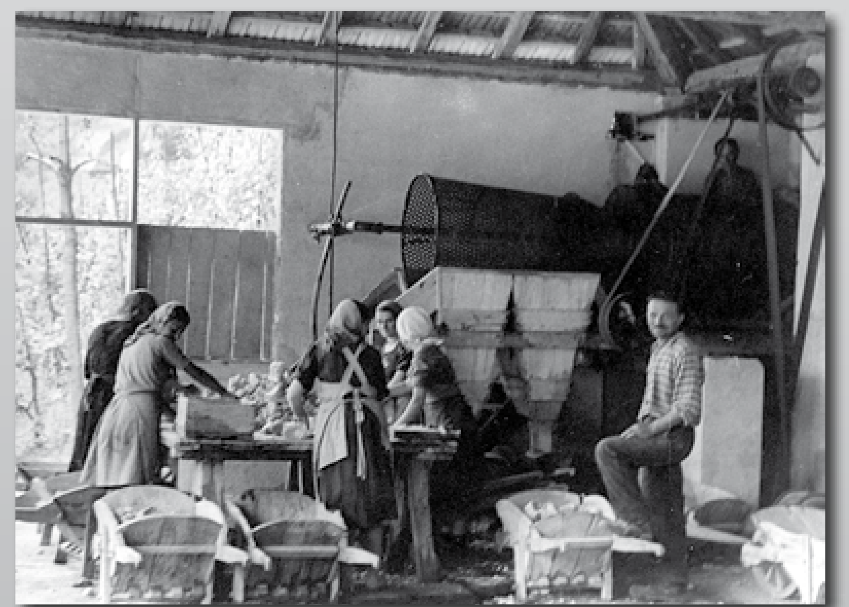
Lavatura e cernita manuale della barite a Darzo, negli anni Quaranta
