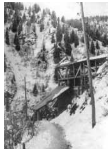
Anni Quaranta: stazione di carico della teleferica con cui il minerale veniva calato a valle a Darzo.
